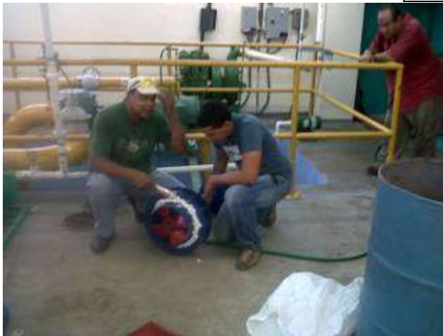
COLOCACIÓN DE SELLO A LA SALIDA DE LA TURBINA
