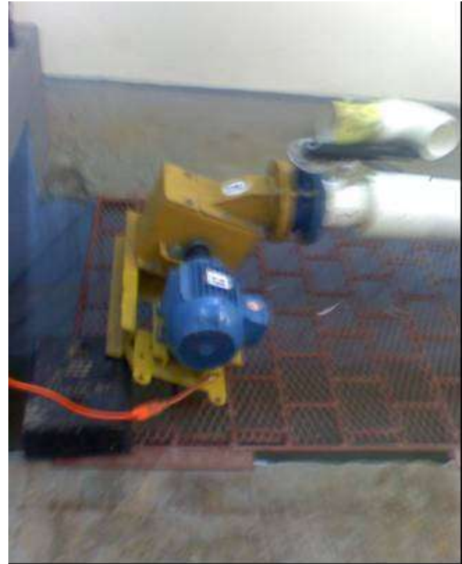
INSTALACIÓN DE LA TURBINA Y EL GENERADOR
